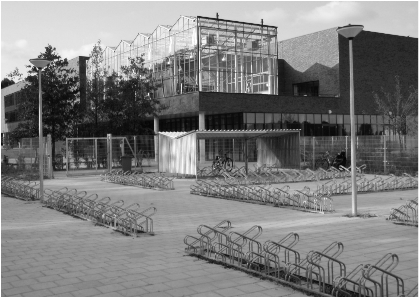
School in Leidschendam-Voorburg met een kasconstructie op het terras. Verlichting, koeling en verwarming én onderhoud vereisen kostenexpertise in de bouw- en beheerfase
